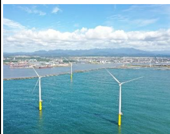
秋田港洋上発電所
